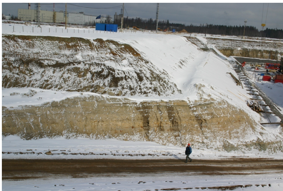
Рисунок 5.3.3.1.3.1.2 - Разрез ломоносовских песчаников (котлован под «ядерный остров», 2009 г.)
